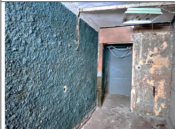
Фото 23. Типичное состояние Объекта оценки
