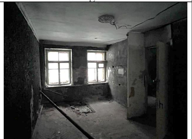
Фото 16. Типичное состояние Объекта оценки
